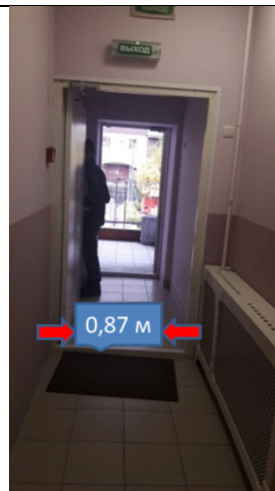
Доступ в учреждение на 1 этаж с пандуса (с улицы)
